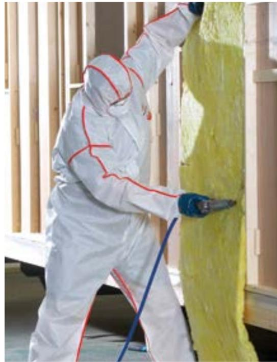
SafeGard™ 76-Version mit SMMS-Gewebe und rot gebundenen Nähten. Speziell zur Erfüllung der französischen Branchenbestimmungen im Umgang mit Asbest entwickelt.
